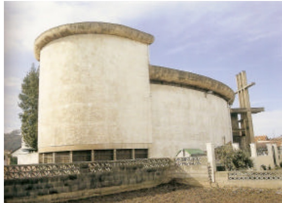
02. Vista desde el ábside, con la crucería de acceso
