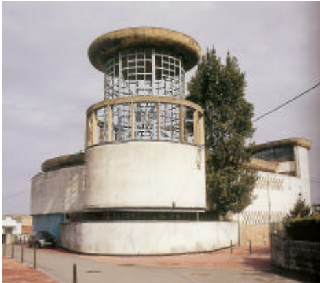
01. Vista lateral desde el sur, con el campanario
